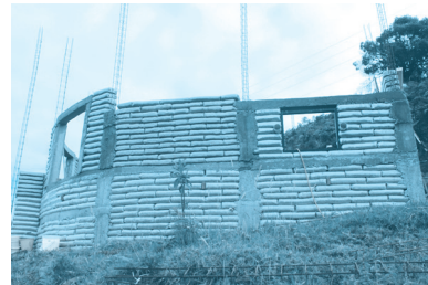
شکل ۲: نمونه‌هایی از ساختمان‌های بنایی محصور شده با کلاف
