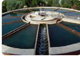
آب در تصفیه‌خانه
